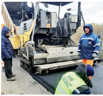
Ремонт трассы «Омск-Тара» продолжится - с. 4
