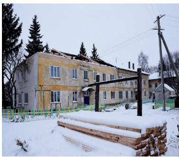
Какие дома ждёт на ремонт в 2021-м - с. 3
